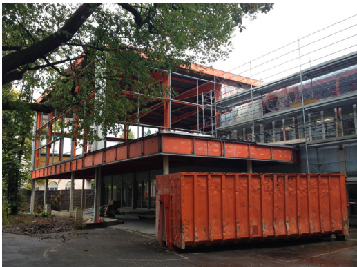
Préparation de la rénovation du gymnase
