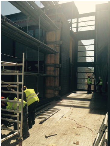
Changement et renforcement de la superstructure des bâtiments scolaires
