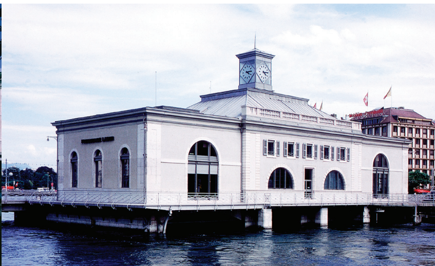
Le corps central et les deux ailes
