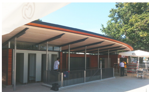
Vue de la terrasse
