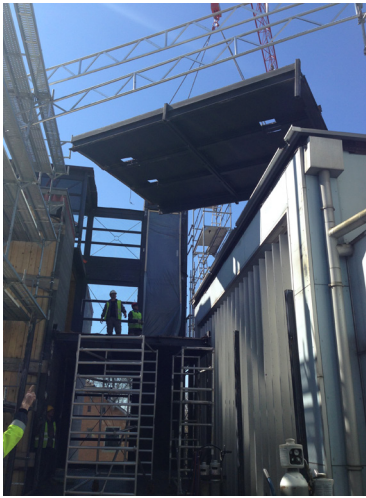
Pose des éléments de superstructure
