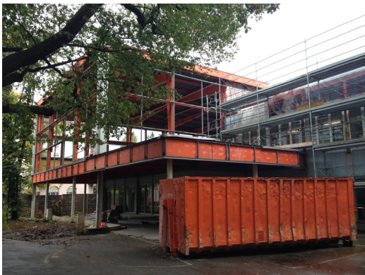
Préparation de la rénovation du gymnase
