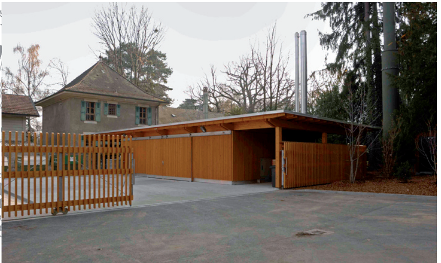
La chaufferie proprement dite est enterrée
