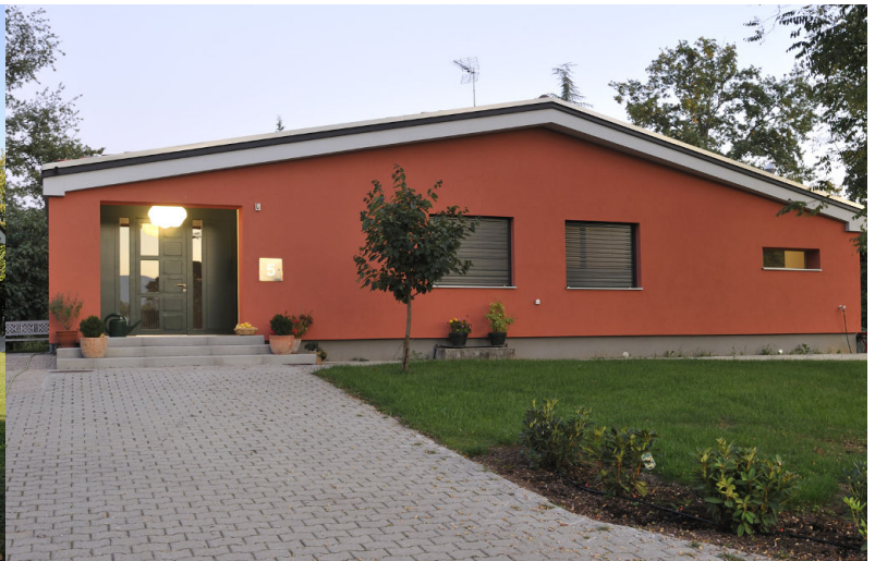
Façade Nord-Ouest, vestibule d'entrée
