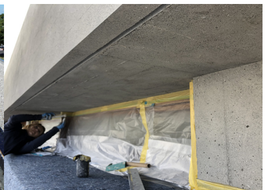
Traitement des bétons en façade
