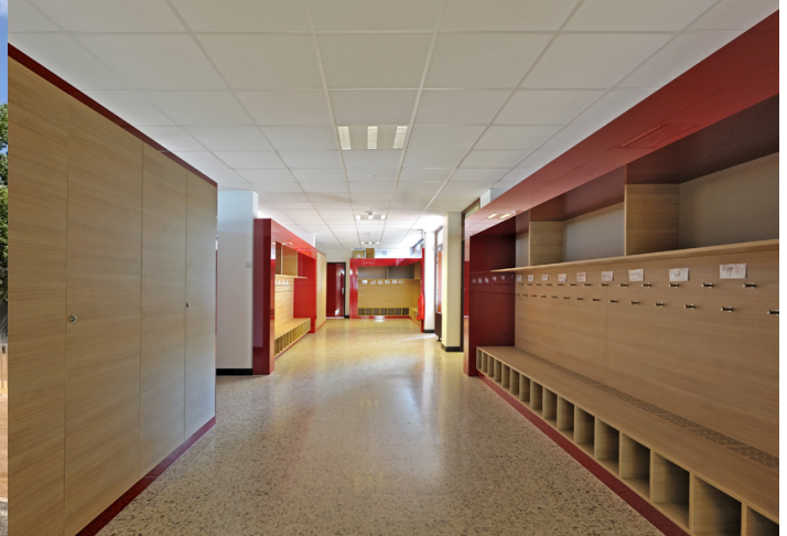
Rénovation des espaces intérieurs
