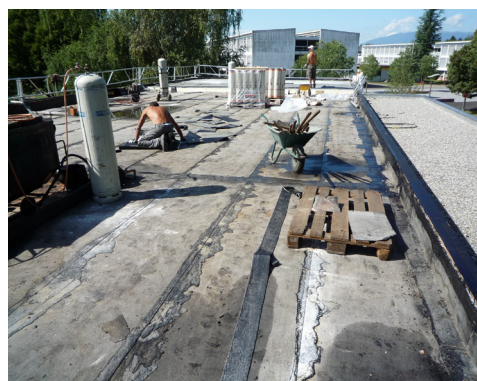
Travaux de rénovation de la toiture
