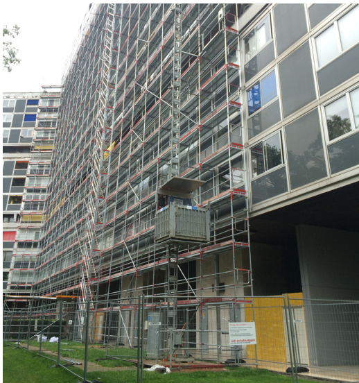
Echafaudage en façade
