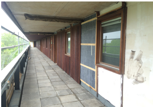
Travaux en cours sur les coursives
