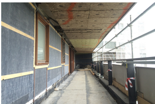
Travaux en cours sur les coursives
