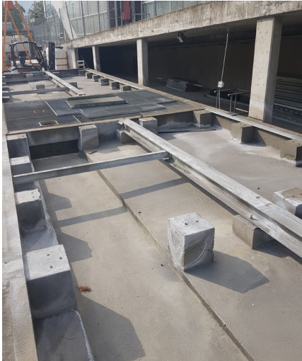
Conformité de la production de froid - socle récepteur
